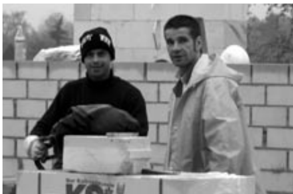
Blick auf die Baustelle: Dennis und Thomas bei der Arbeit
