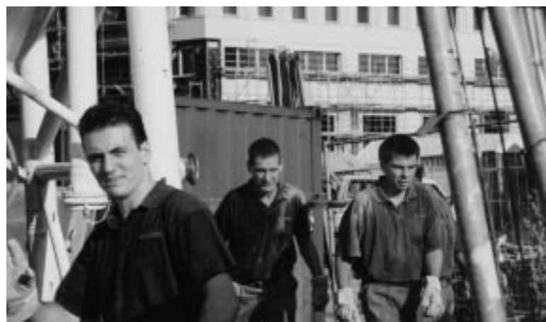
Tatkräftig und engagiert: Alexander, Fritz und Hassan entsorgen den groben Bauschutt
